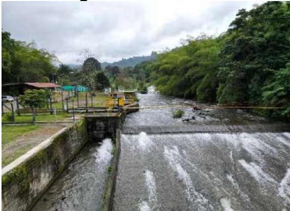
Bocatoma EPA ESP – Salento Quindío
