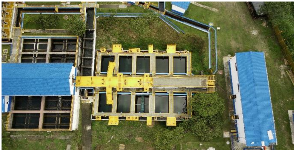
Ubicación: Planta de Tratamiento de Agua Potable - Regivit
